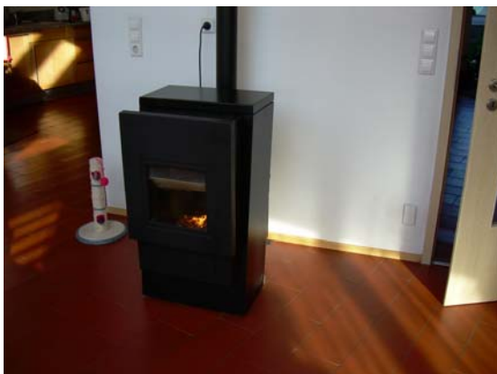
Heizung nach der Sanierung
